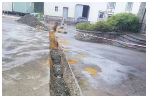
Remplacement conduite d'eau à Recogne
