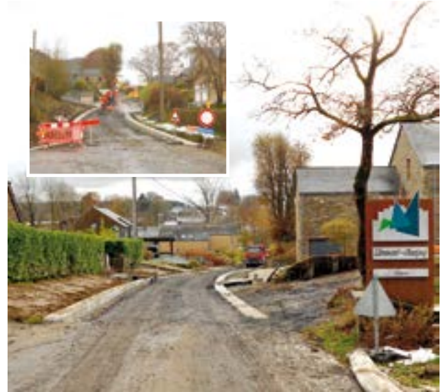
Nouvelle voirie, rue des Colais à Ourt
