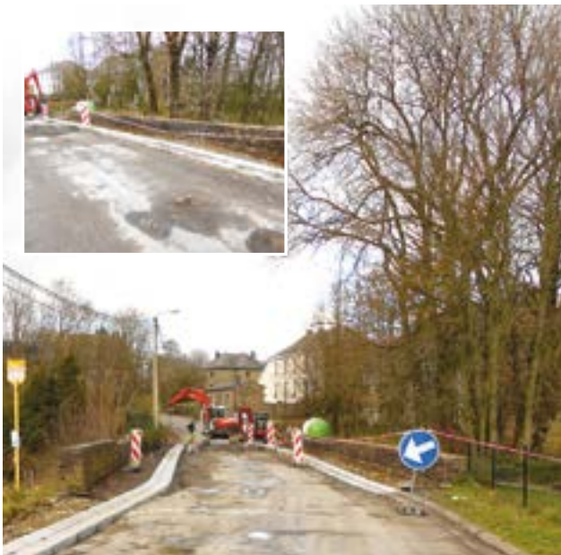
Nouveau revêtement et pose de bordures filets d'eau à la rue des écoles à Seviscourt
