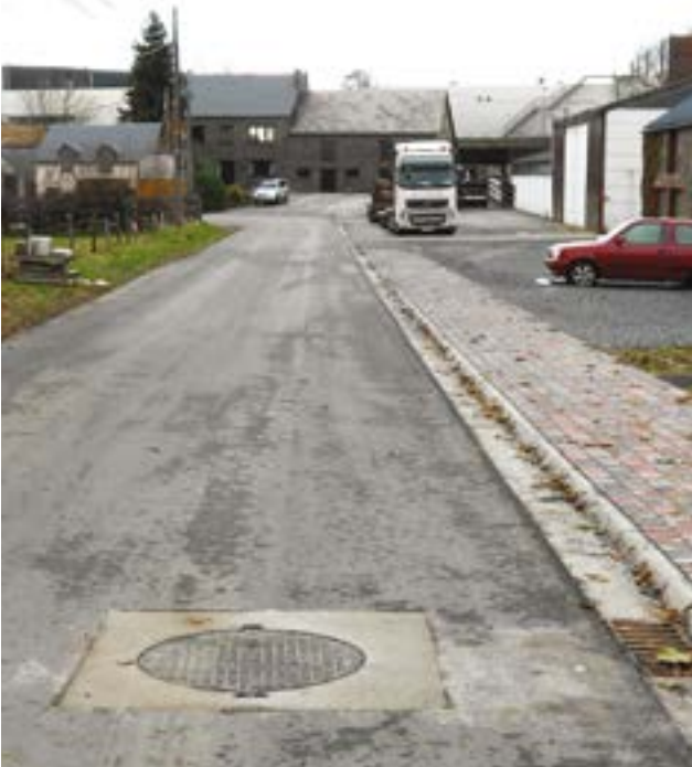
Remplacement distribution d'eau à Recogne, rue des bacs, à Sberchamps et Nimbermont et réfection voirie. Les conduites d'eau étant encore en fonte grise, leur renouvellement par du polyéthylène était impératif
